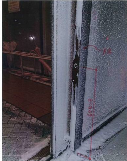
写真2 雪を手で払い落として見えたセンサー
